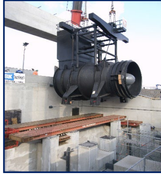
Gemaal IJmuiden, Stork & Pentair. Behorend tot s'werelds grootste pompen).
