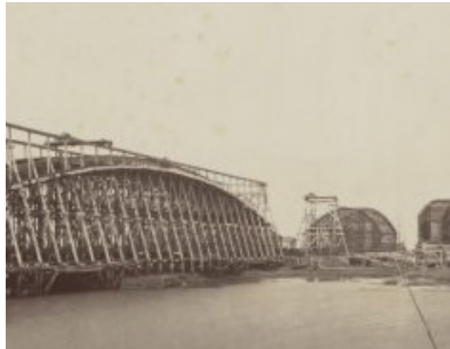
Fig 07, bouw van de overspanningen voor de spoorwegbrug over het Hollandsch Diep bij Moerdijk, 1871, (foto: Oosterhuis, Pieter, Nationaal Archief /Fotocollectie Rijkswaterstaat).
