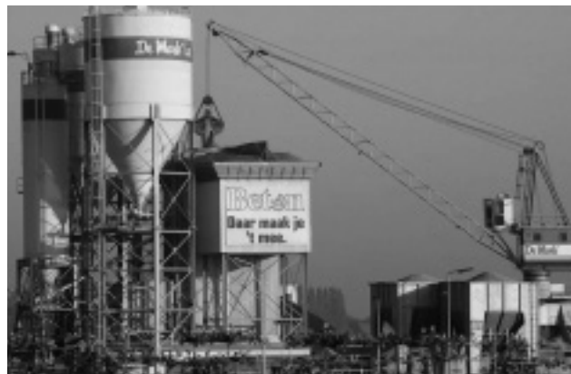
Fig. 31 Betoncentrale 'De Mark' te Oud Gastel, ( www.bcwestbrabant.nl )
