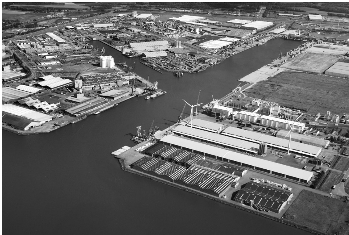
Fig. 29 De Haven van Moerdijk, (Beeldbank Rijkswaterstaat, 2016)
